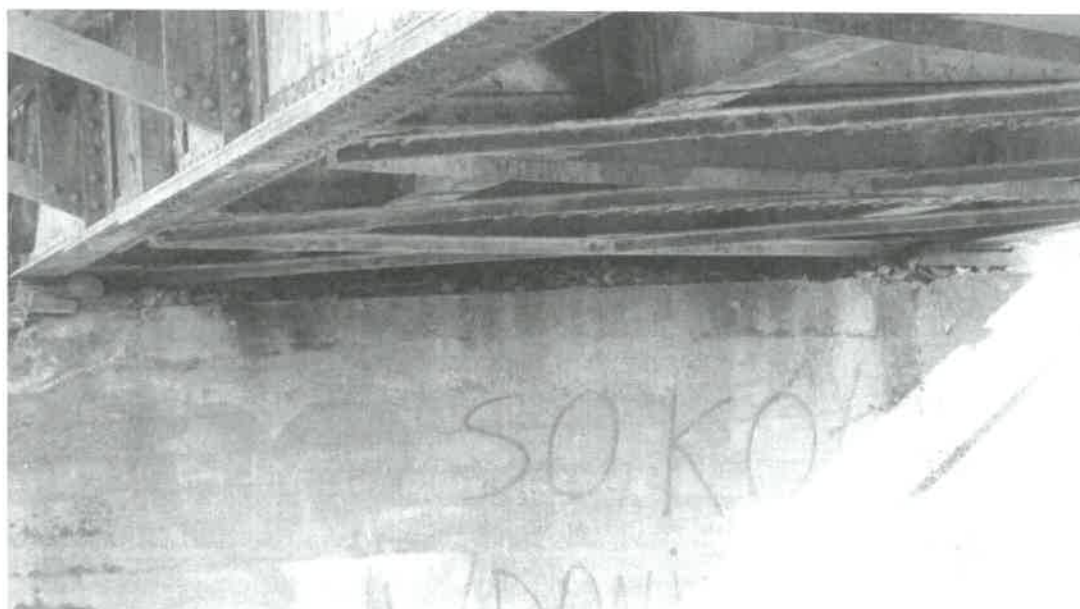
Fot.2 Widok na dolną powierzchnię ustroju nośnego
