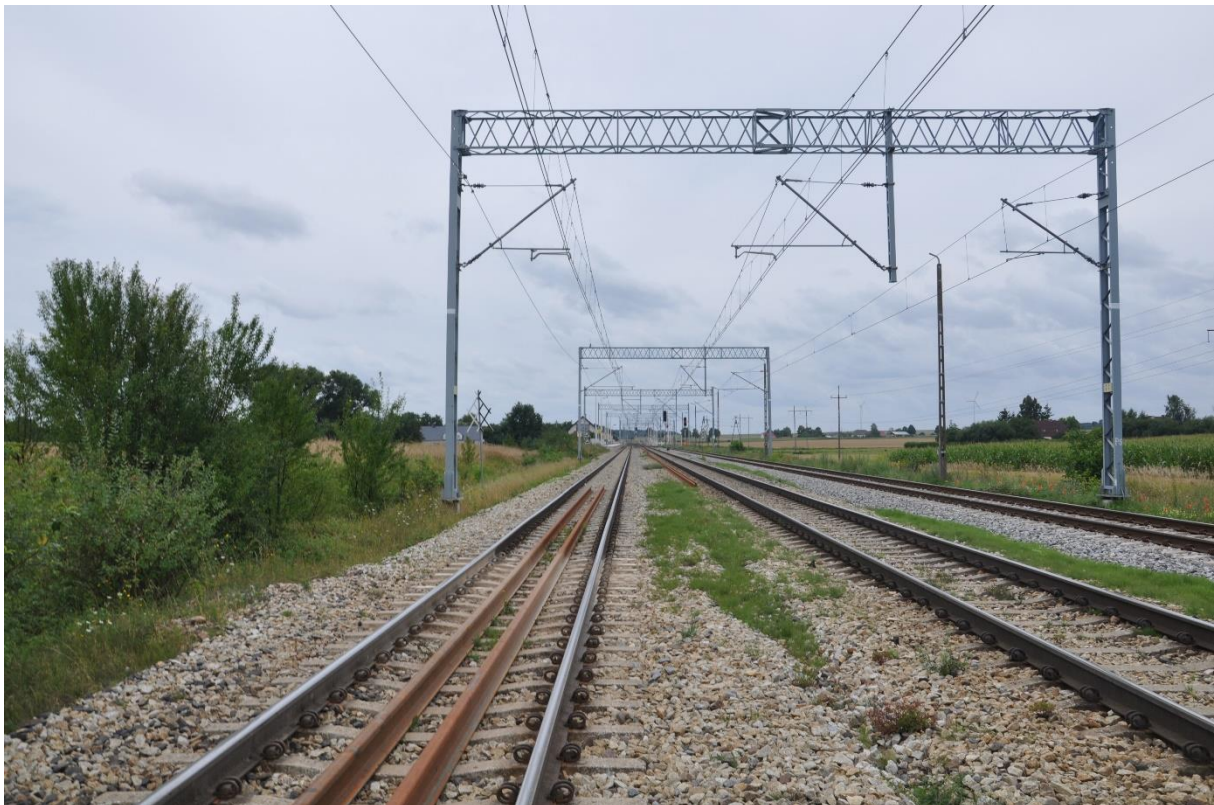
Zdjęcie 2 Stacja Wydartowo, widok w kier. Gniezna. Widoczny wychłap w torze nr 1
