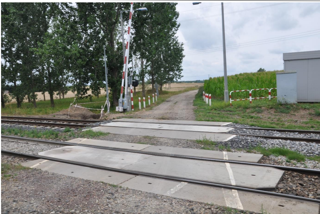
Zdjęcie 1 Przejazd w km 69,131
