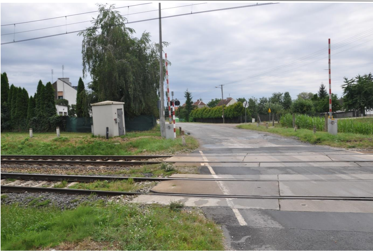
Zdjęcie 5 Przejazd w km 58,054
