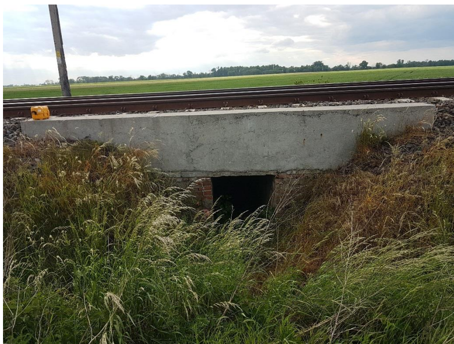
Fot. 1 Widok przedmiotowego przepustu od strony toru nr 1.
