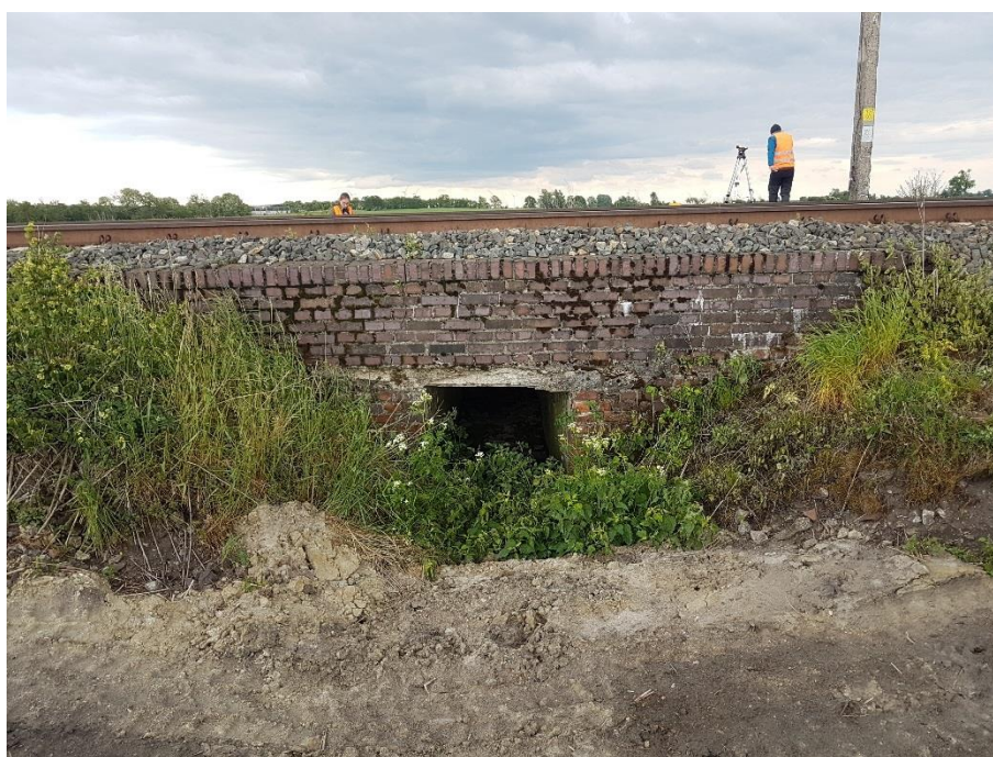
Fot. 2 Widok przedmiotowego przepustu od strony toru nr 2.
