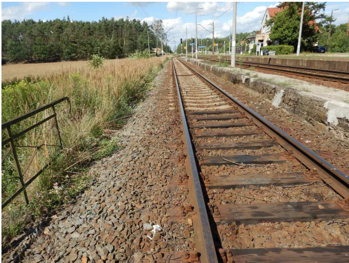
Zdj. 28 Widok na nawierzchnie.
