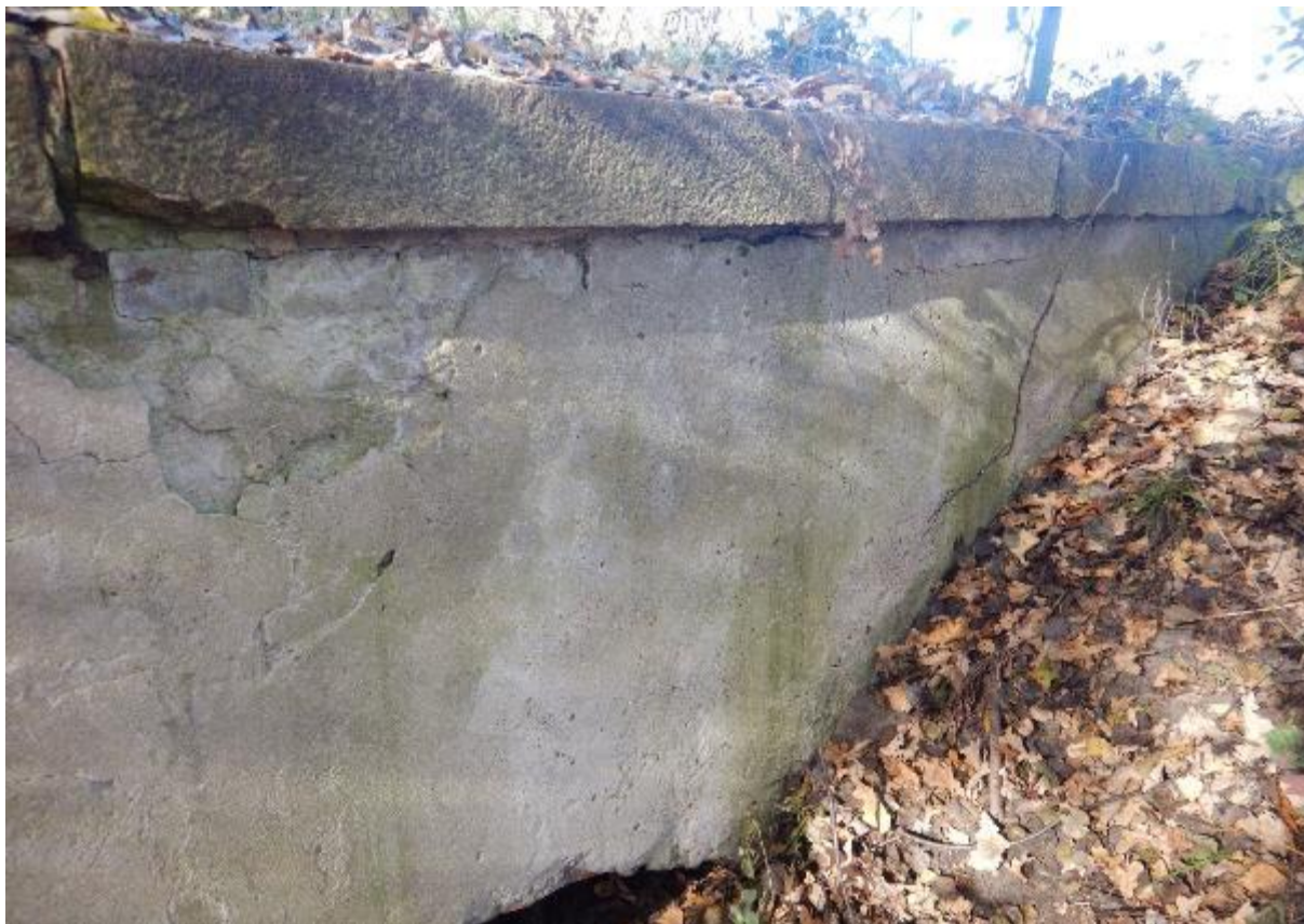
Zdj. 62 Widok na korpus ściany czołowej – ubytki tynku, spękania powierzchniowe.
