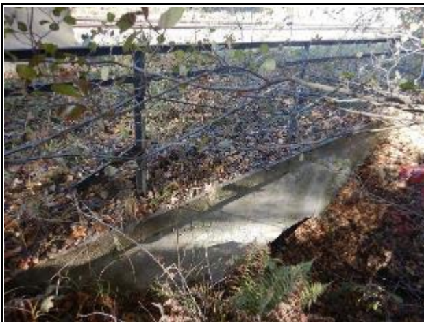
Zdj. 49 Widok na głowicę lewą
