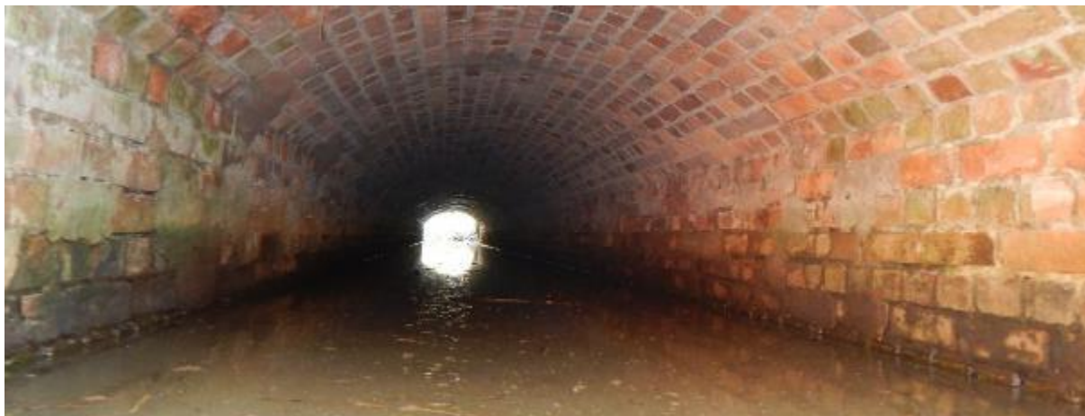
Zdj. 33 Widok na ściany przepustu.
