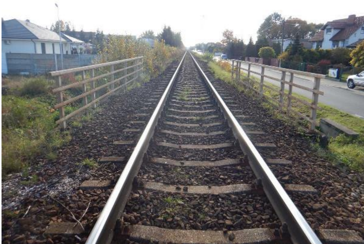
Zdj. 5 Widok na nawierzchnie.
