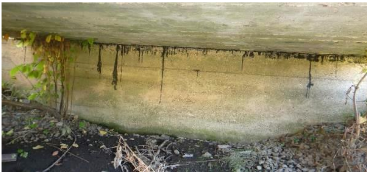
Zdj. 13 Widok na przyczółek
