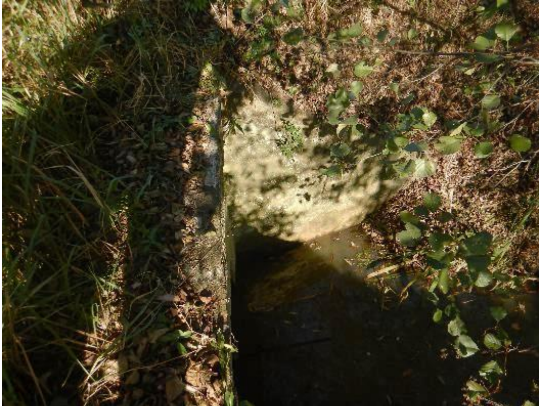
Zdj. 36 Widok na głowicę – pęknięcie i odspojenie skrzydła, wykruszenie betonu na krawędzi głowicy – widoczna nieregularna struktura betonu.
