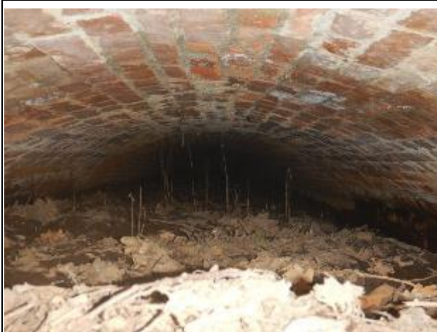
Zdj. 51 Widok wnętrza przepustu
