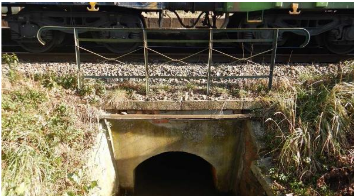
Zdj. 48 Widok na balustradę na głowicy prawej.
