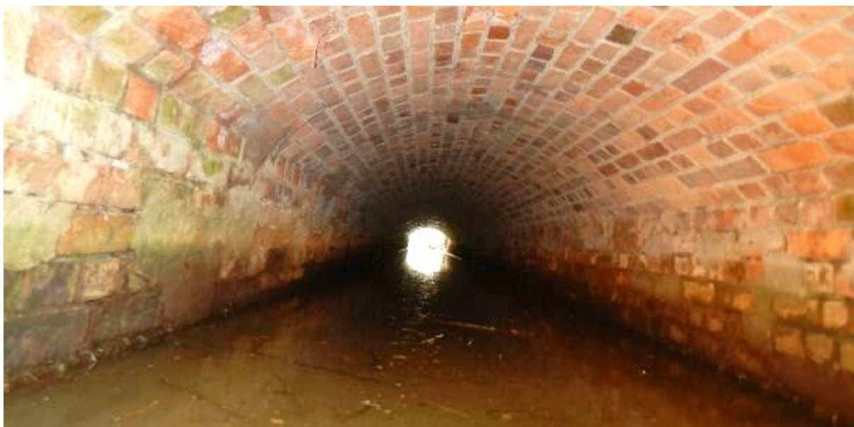
Zdj. 40 Widok na powierzchnię konstrukcji w części przelotowej – przecieki na ścianach.
