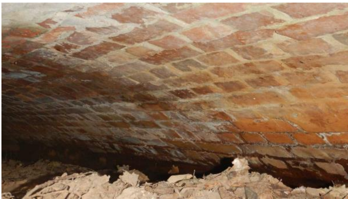
Zdj. 55 Widok wnętrza przepustu od strony lewej – ślady przecieków, spękania powierzchni
