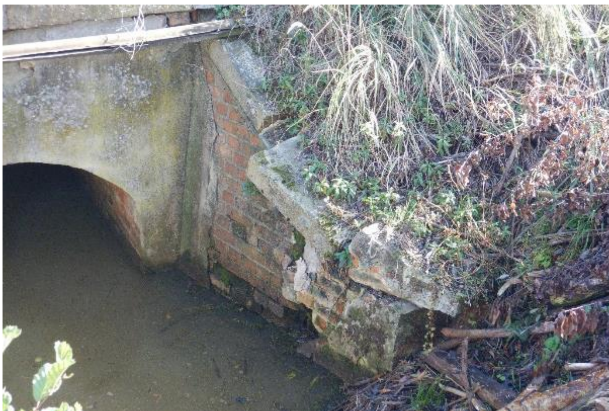
Zdj. 38 Widok na skrzydło – rozluźnienie i przemieszczenie bloków kamiennych.
