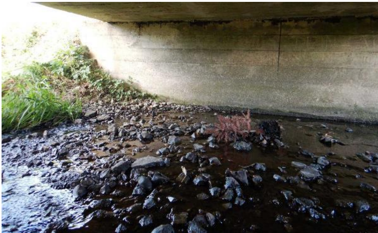
Zdj. 20 Widok na dno przeszkody – kamień
