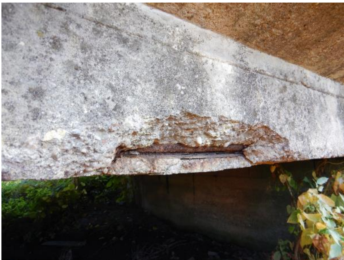
Zdj. 9 Widok na uszkodzenia przęsła w postaci ubytków betonu z odsłonięciem zbrojenia, korozji zbrojenia.
