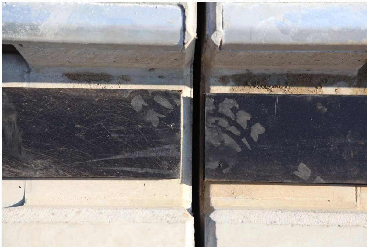
Ułożenie wstęgi podkładki podszynowej na długości płyty, bez przysłaniania szczeliny między płytami
