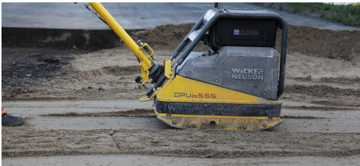
Zagęszczanie mechaniczne warstwy wyrównawczej.
