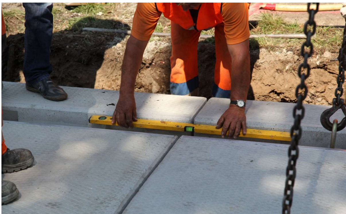
Sprawdzanie prawidłowego położenia płyt w kanałach szynowych przy pomocy poziomnicy.
