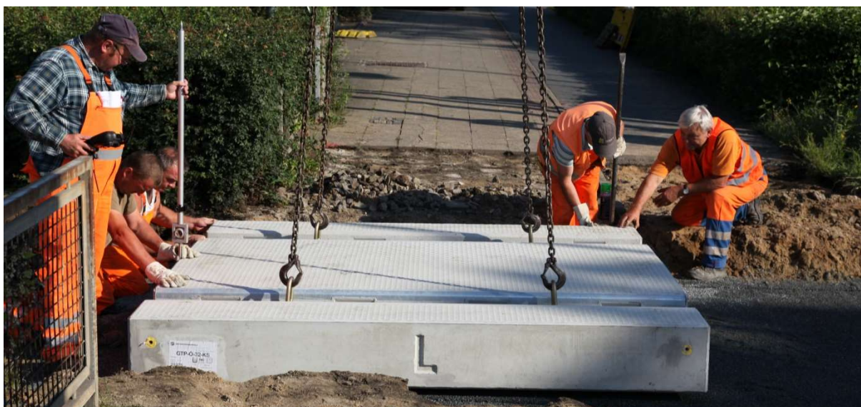
Ustalanie położenia pierwszej płyty
