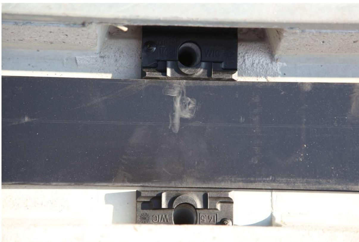
Ułożenie w kanale szynowym przewodnic kątowych zgodnie z projektem – szczególnie ważne na łukach.
