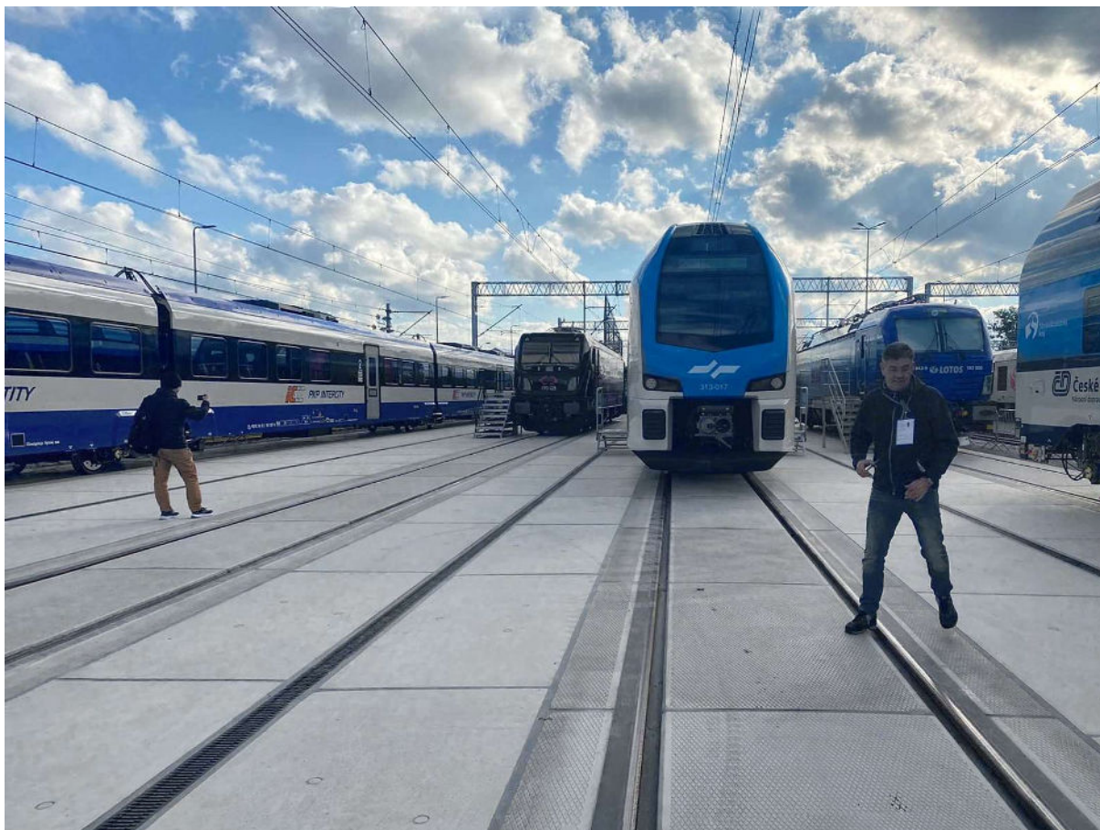
Przykład prawidłowego/ estetycznego wypełniania dylatacji oraz kanałów szynowych
