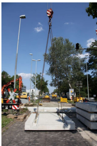
Przykład prawidłowego montażu zawiesi przy podnoszeniu płyt systemu GTP przy pomocy kotew typu PLA-FF3.0-9 zabudowanych w płycie i uchwyty transportowych PLA-RK-R1 5.0.
