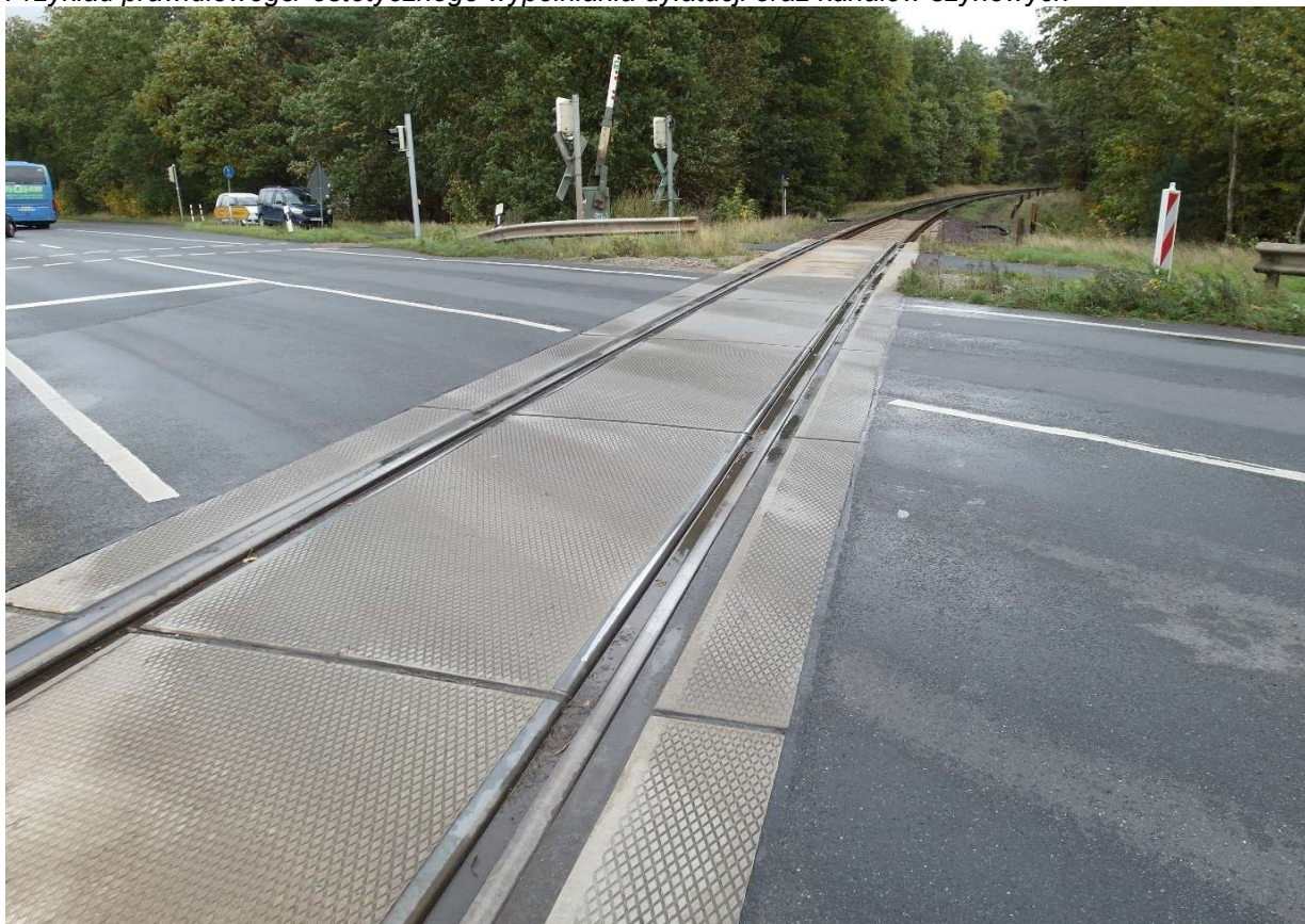
Przykład prawidłowego/ estetycznego wypełniania dylatacji oraz kanałów szynowych
