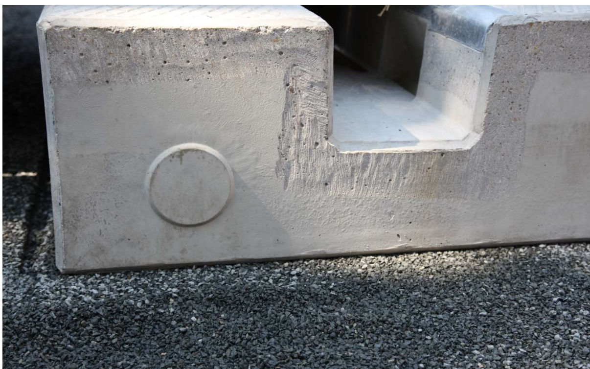
Lekkie zeszlifowanie krawędzi czołowych płyt dla lepszej przyczepności fug (mas uszczelniających).
