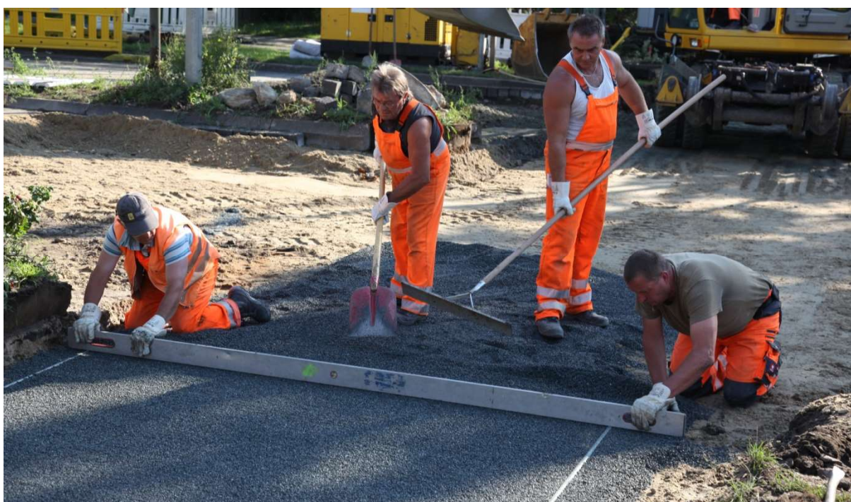
Układanie ramy pod płyty GTP wytworzona w ramach jednego procesu pracy (jednego przeciągnięcia łątką brukarską, bez ubijania).
