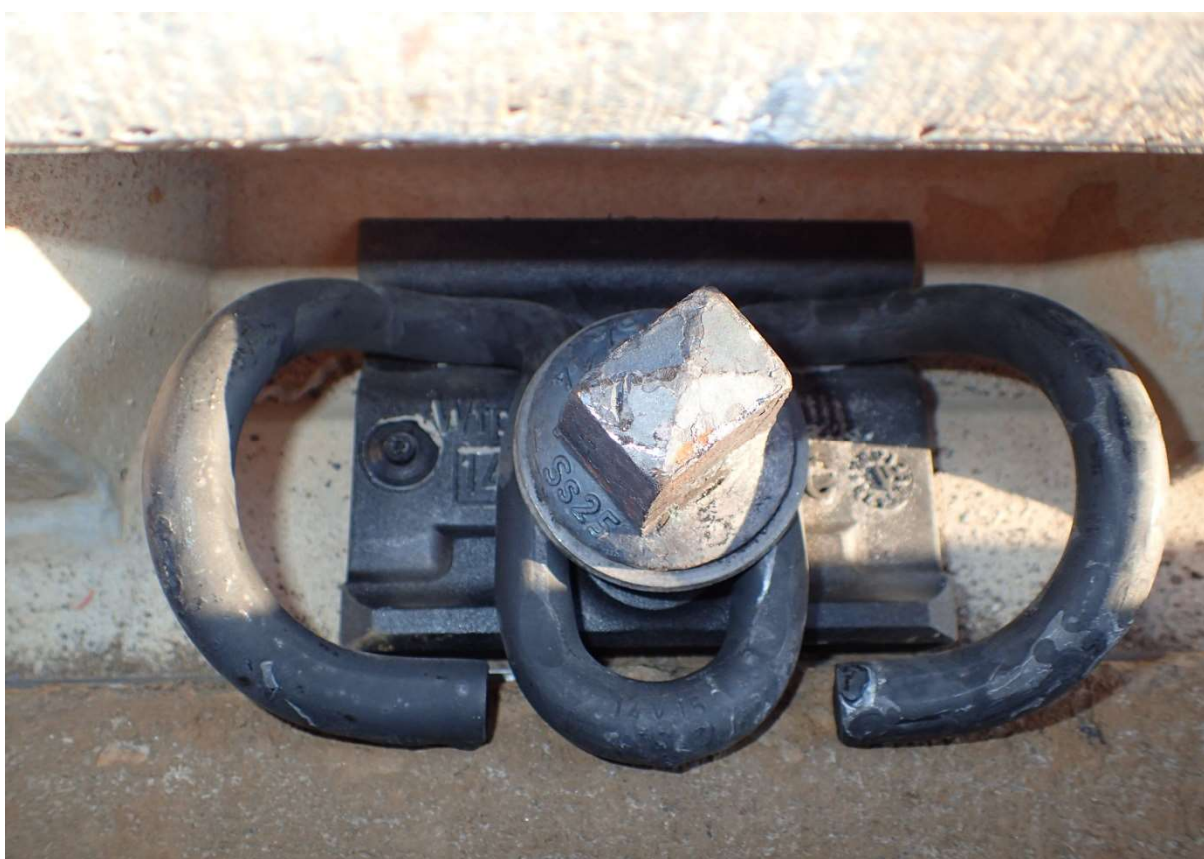
Montaż łapek sprężystych i wkrętów systemu W14 lub W14/BFL wraz z dokręceniem przy pomocy ręcznej zakrętkarki lub klucza.
