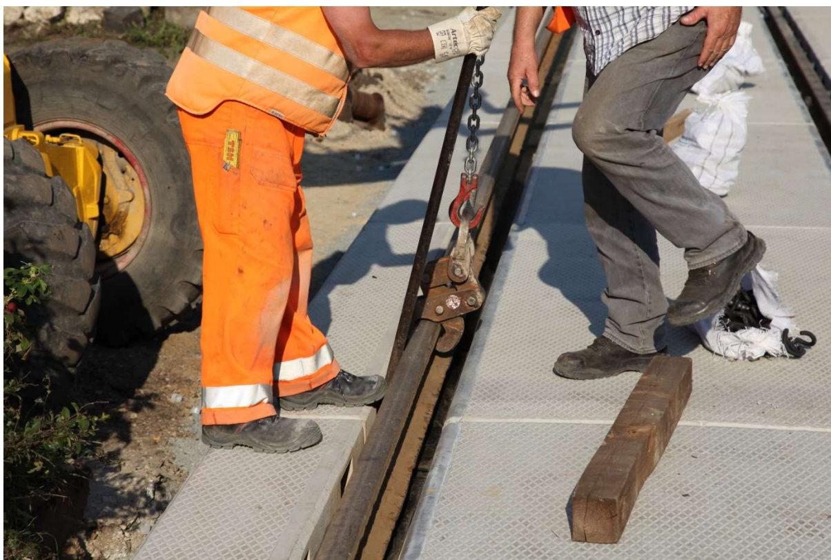
Włożenie szyny do kanału szynowego.
