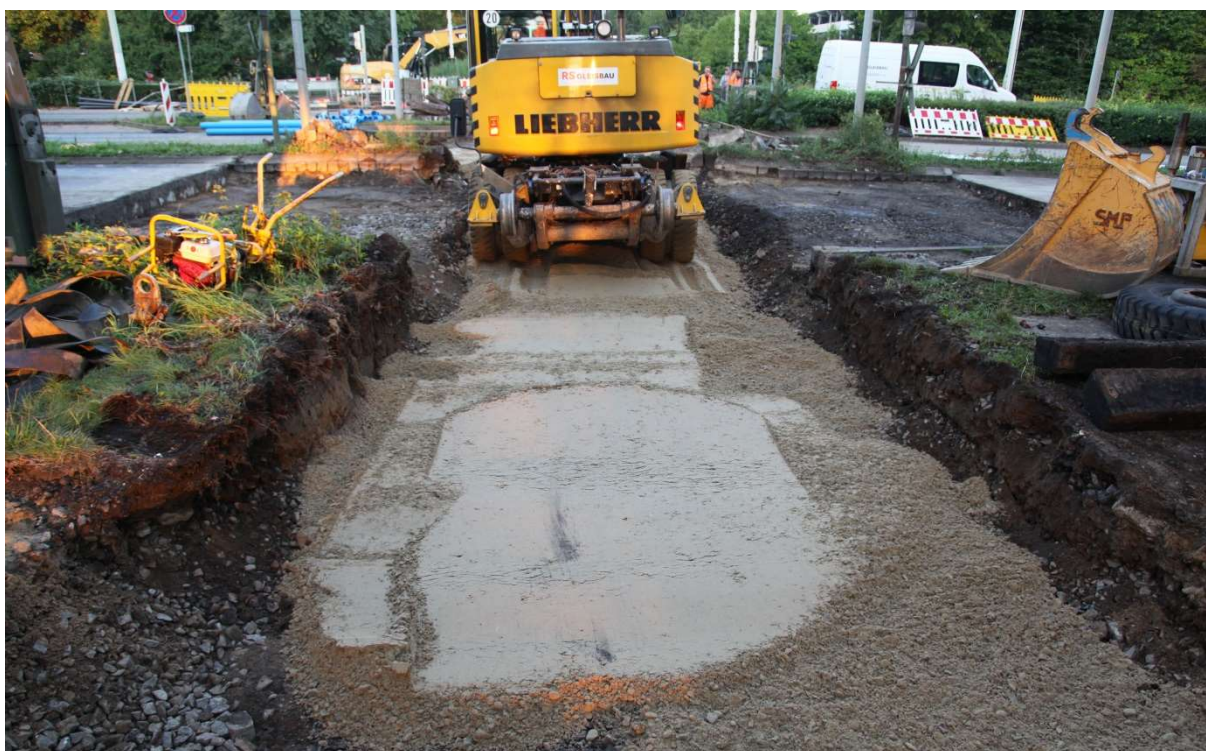
Widok koryta i zagęszczonej warstwy nośnej.
