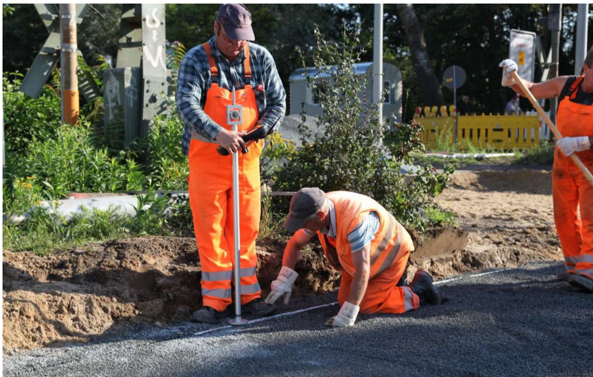
Określanie położenia prowadnic do utworzenia ramy
