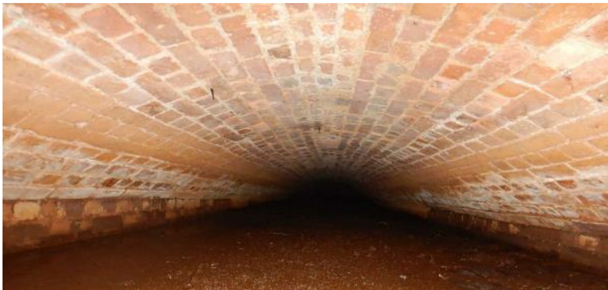
Zdj. 56 Widok wnętrza przepustu od strony prawej – ślady przecieków, spękania powierzchniowe
