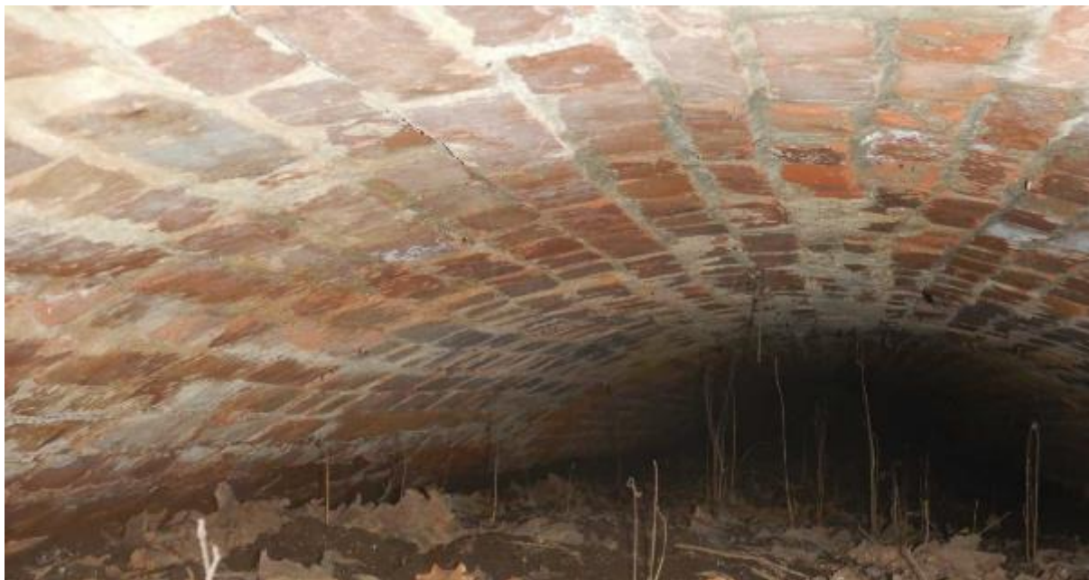
Zdj. 54 Widok wnętrza przepustu od strony lewej – ślady przecieków, spękania powierzchni.
