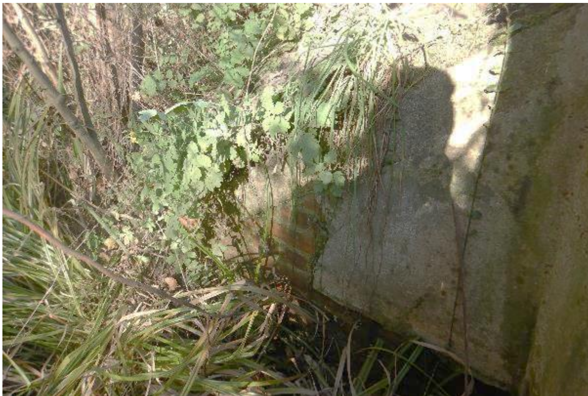
Zdj. 65 Widok na skrzydło głowicy prawej – rysy i spękania powierzchniowe, wegetacja mchu i porostów.
