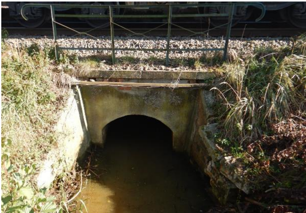
Zdj. 37 Widok ogólny na głowicę prawą – wegetacja mchu i porostów, pęknięcia skrzydeł, rysy i spękania powierzchniowe.
