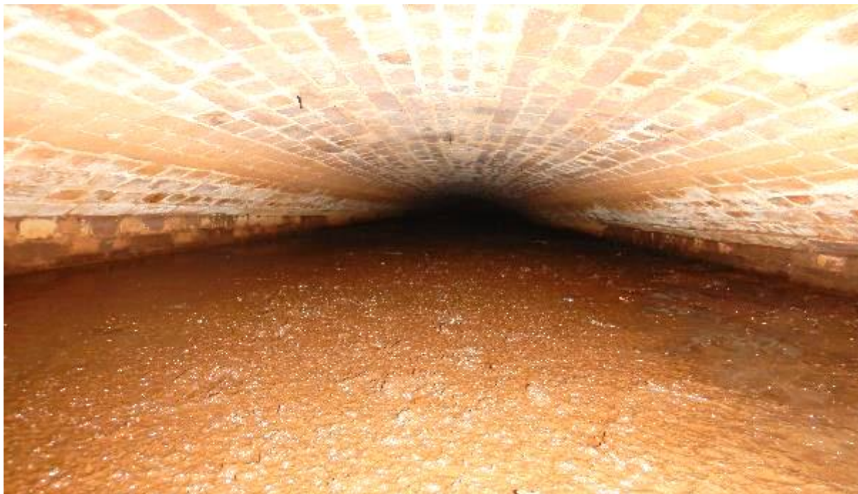
Zdj. 67 Widok na ścianę przepustu – przecieki.
