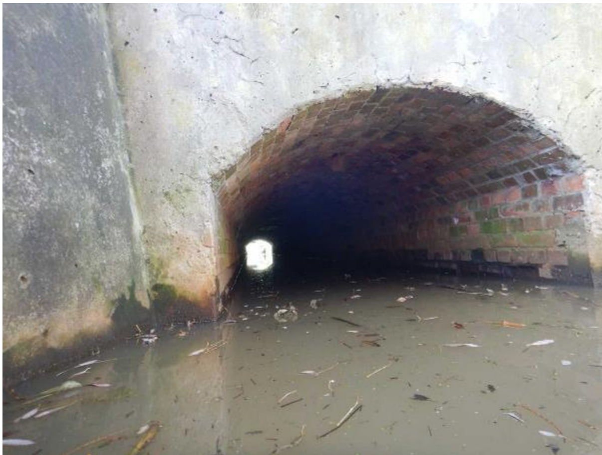
Zdj. 46 Widok na dno przepustu – dno zamulone i zatopione.
