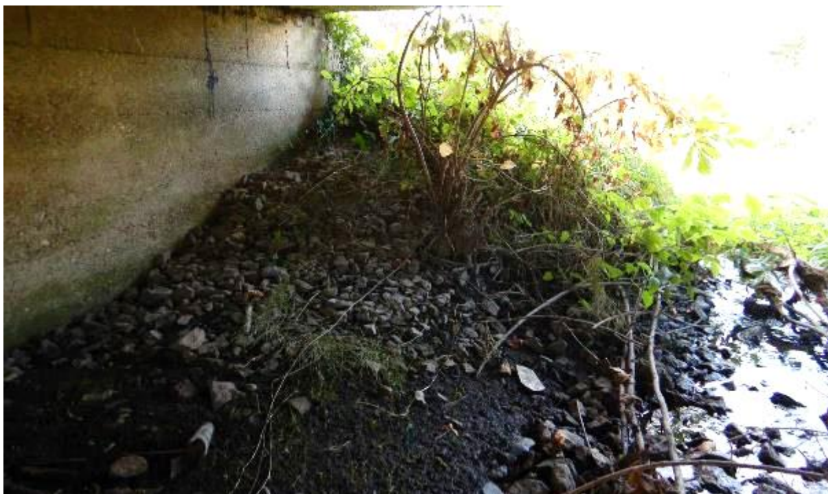
Zdj. 19 Widok na osuniecie mas ziemnych skarpy do koryta przeszkody.
