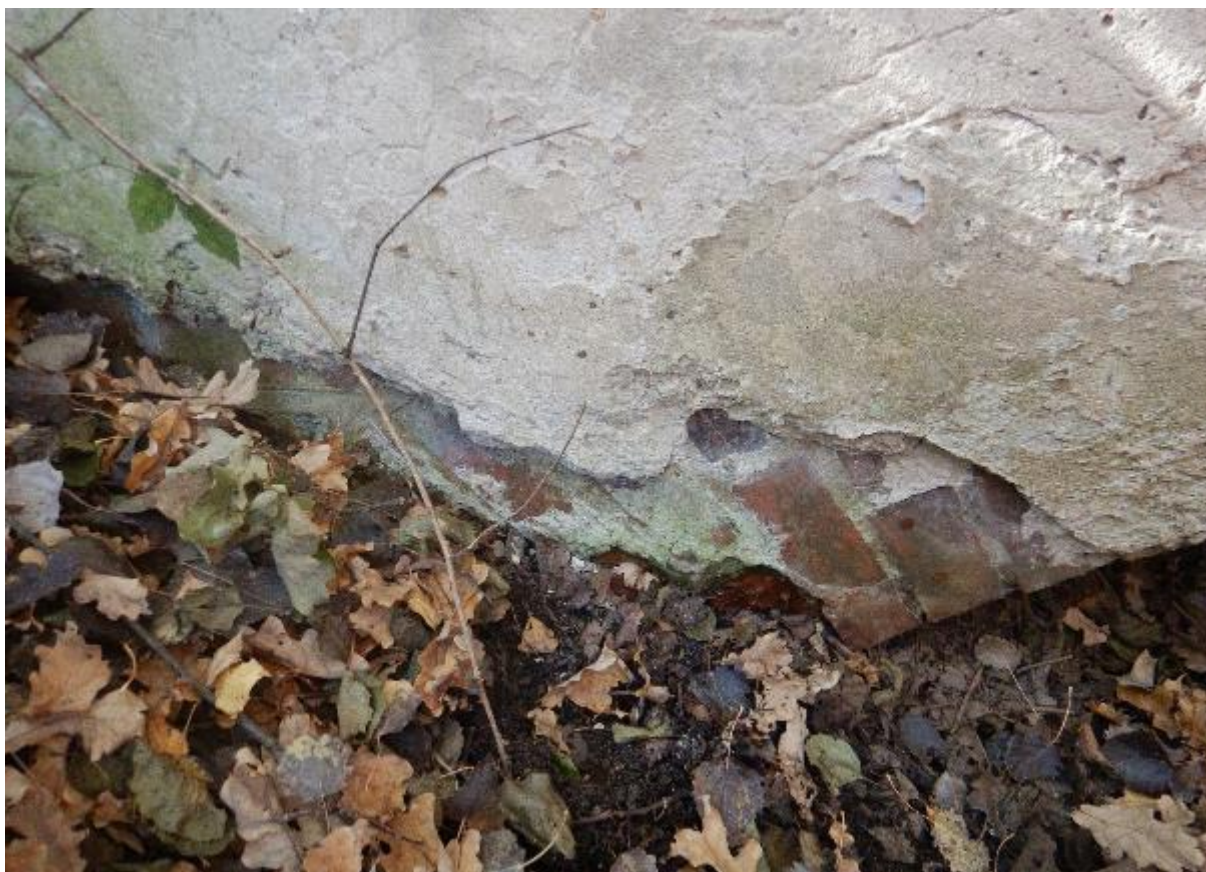
Zdj. 63 Widok na głowicę – ubytki tynku.
