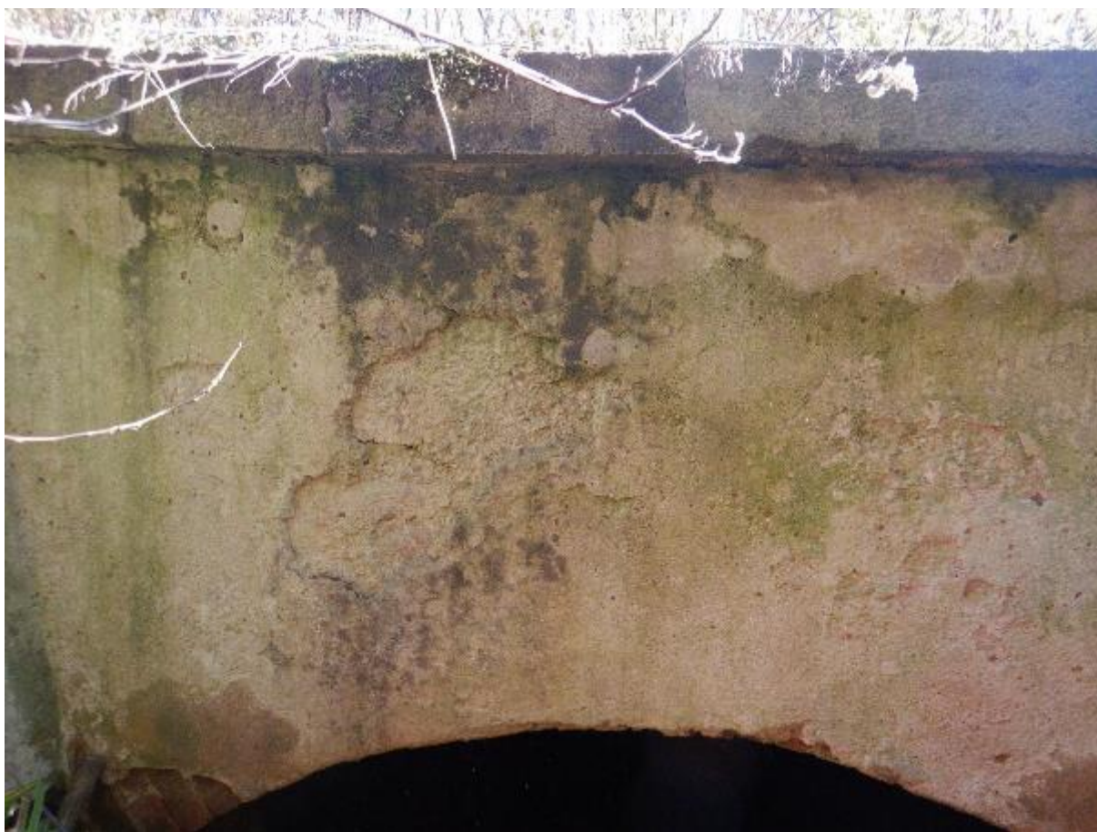
Zdj. 64 Widok na ścianę czołową głowicy prawej – rysy i spękania powierzchniowe, wegetacja mchu i porostów.
