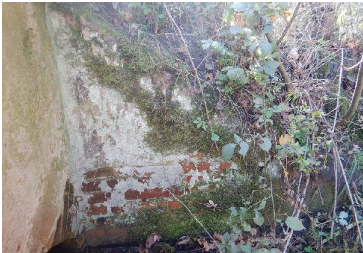
Zdj. 66 Widok na skrzydło głowicy prawej – ubytki tynku, wegetacja mchu i porostów.
