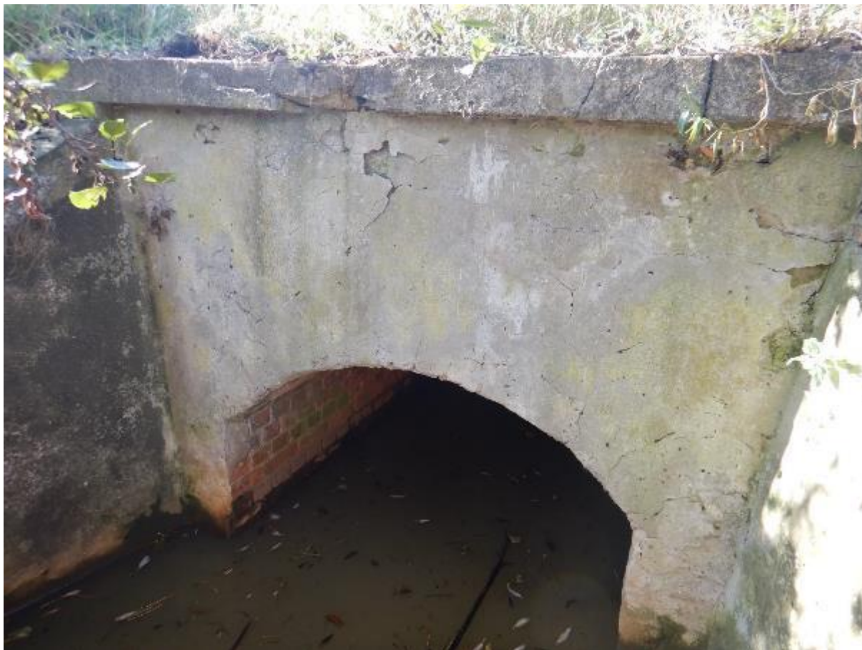
Zdj. 34 Widok ogólny na głowicę lewą – wegetacja mchu i porostów, spękania powierzchniowe.
