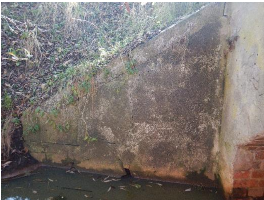
Zdj. 35 Widok na skrzydło – pęknięcie, wegetacja mchu i porostów.
