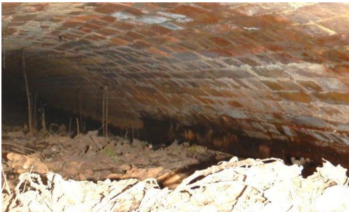
Zdj. 68 Widok na ścianę przepustu – przecieki.
