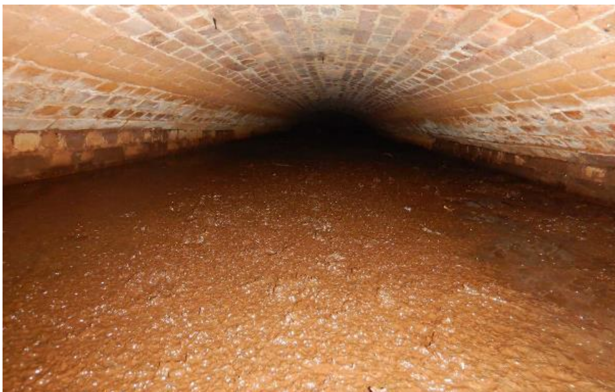
Zdj. 73 Widok na zamulone dno przepustu.
