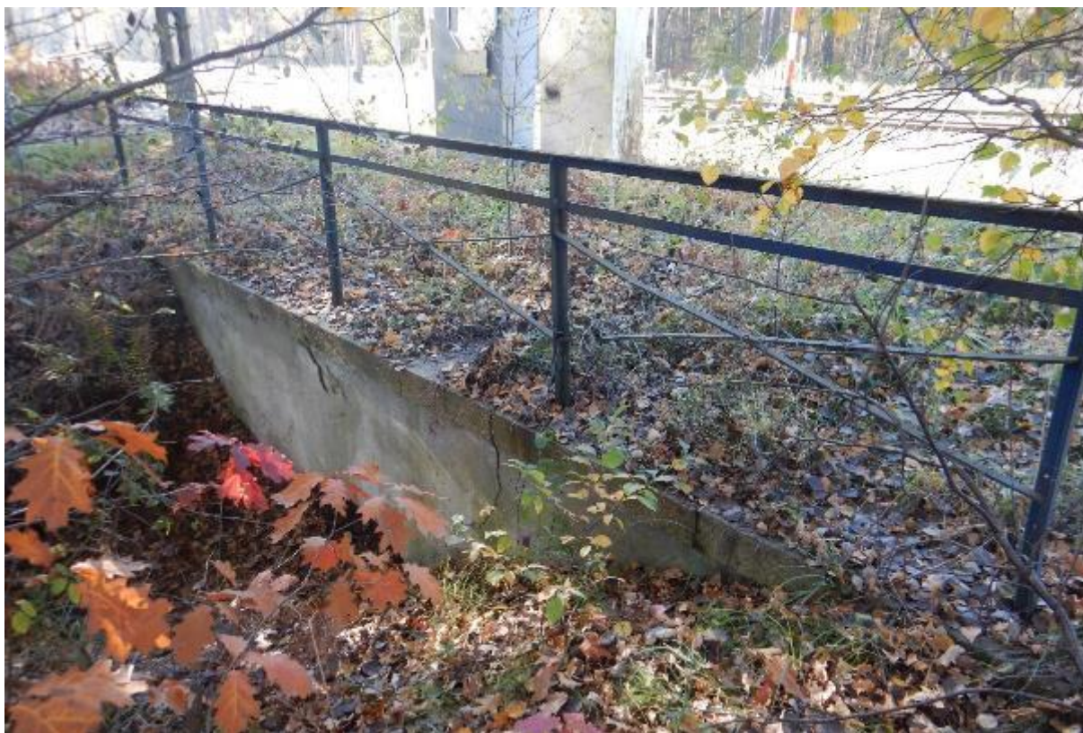
Zdj. 61 Widok ogólny na głowicę lewą – ubytki i spękania otuliny.
