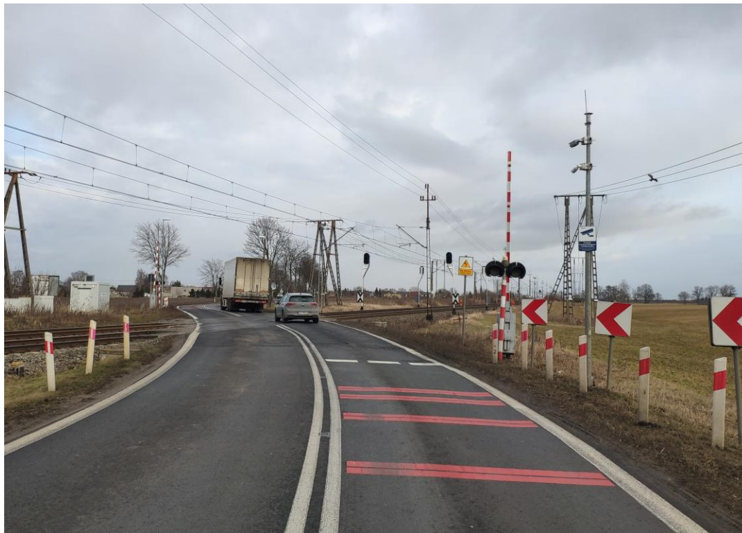
Zdjęcie 1. Przejazd kolejowo-drogowy kat. B w km 339+290
